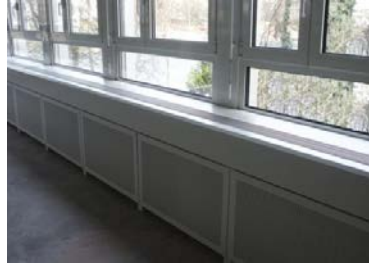
Brüstungskanäle, Brüstungsverkleidungen
