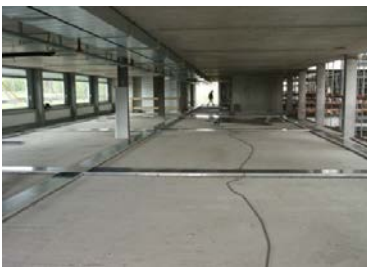
Bodenkanäle, Kombinationslösungen Elektro - Heizung - Quellluft
