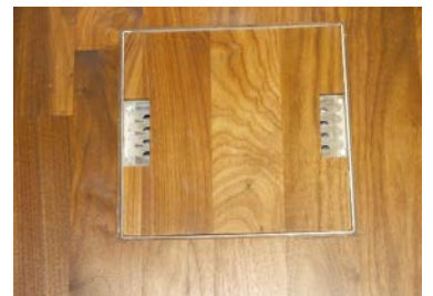
Bodenkanäle, Kombinationslösungen Elektro - Heizung - Quellluft
