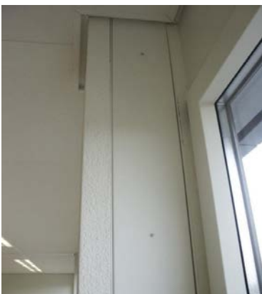
Erschliessungskanäle, Haustechnikcenter, Steigzonenverkleidungen
